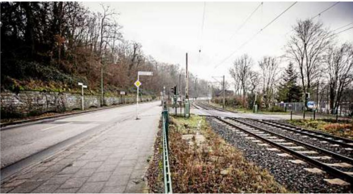
Geplant ist der neue Geh- und Radweg von Überrauch nach Kupferdreh zwischen dem östlichen Ruhrufer und der Bahntrasse der Linie S9.
