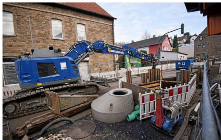
Der Hinsbecker Berg ist wegen der Bauarbeiten der Stadtwerke derzeit gesperrt.
