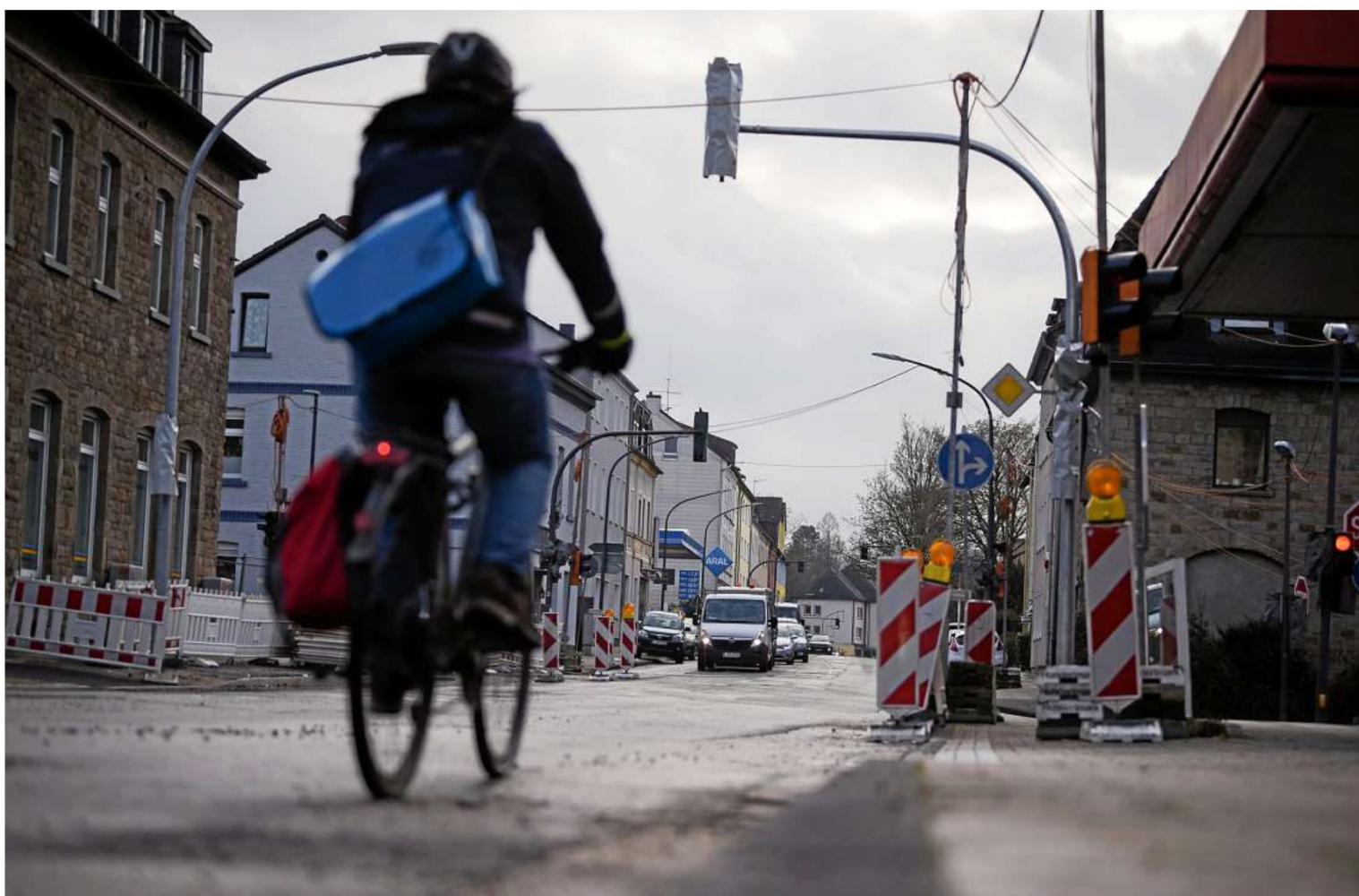
Die Kanalbauarbeiten auf der Kupferdreher Straße nähern sich ihrem Ende. Die Stadt will nun mehr Platz für Radfahrer schaffen. TASSOS/FFS
