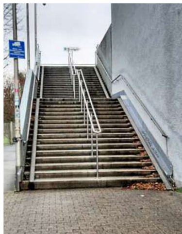
Am Aufgang wird die Aufstiegshilfe für Fahrräder (Metallschiene) demontiert. PT
