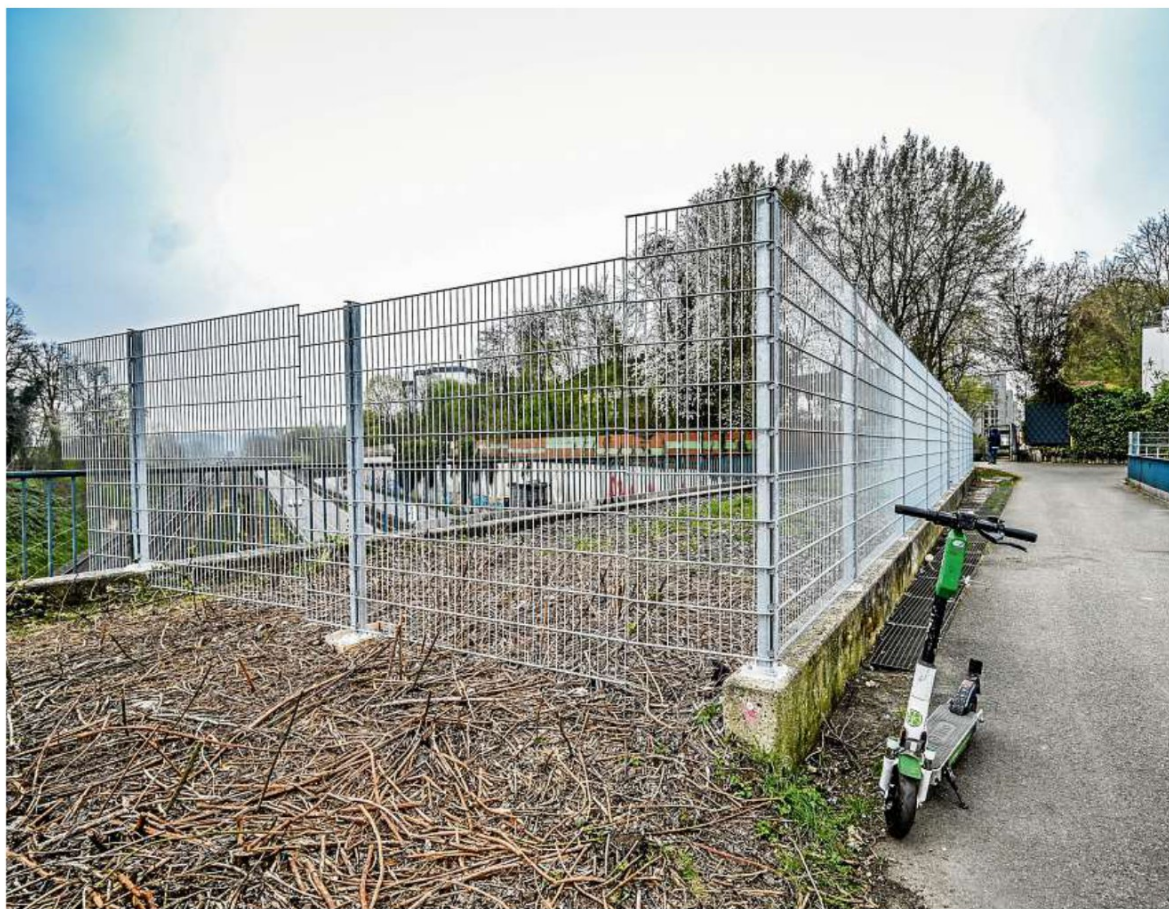
Die ehemalige Gleistrasse ist auf der Brücke über der A-52-Anschlussstelle Süd eingezäunt. FOTOS: KERSTIN KOKOSKA
