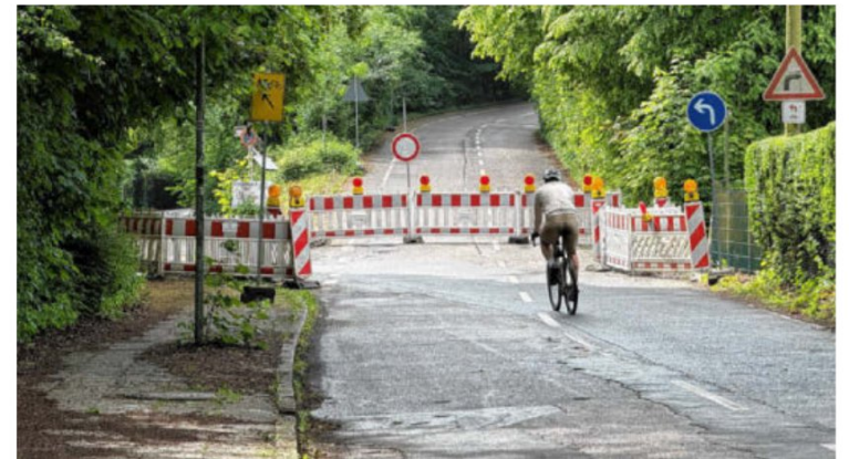
Die Straße Stauseebogen ist ab der Stichstraße gesperrt, derzeit können Autos und Räder über untere Stichstraße ausweichen.
