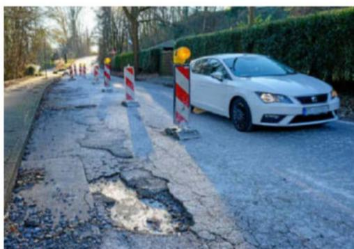
Gutachten haben ergeben, dass hier eine geringe Tragfähigkeit vorliegt, deshalb ist es erforderlich, die Fahrbahn mit Untergrundverbesserungen zu erneuern, um langfristig die Verkehrssicherheit gewährleisten zu können.
