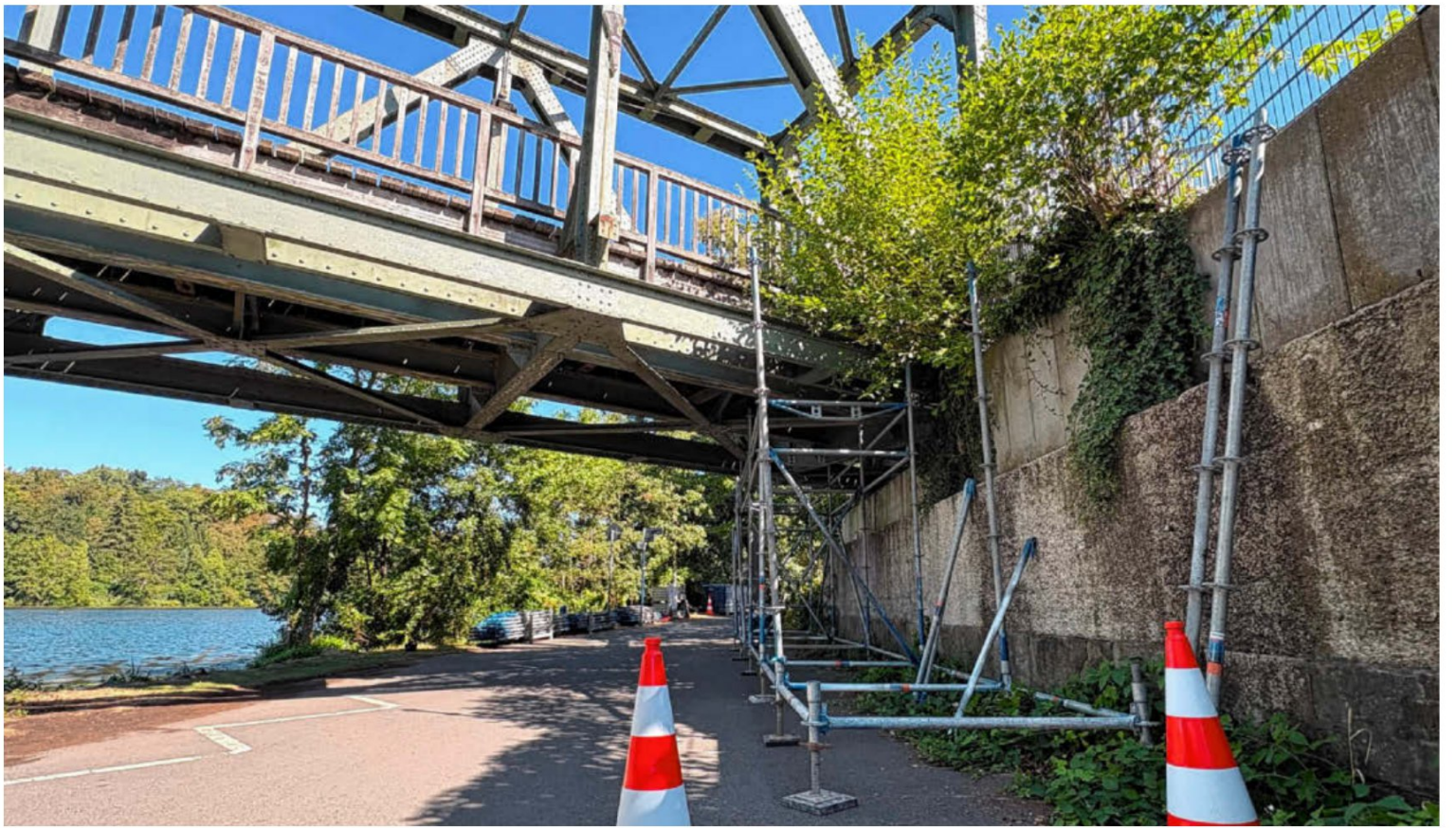
An der ehemaligen Eisenbahnbrücke am Baldeneysee werden Gerüste für die Sanierungsarbeiten aufgebaut.
